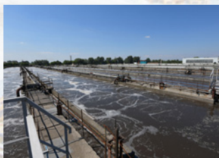
Реконструкция биологических очистных сооружений канализации Казани
