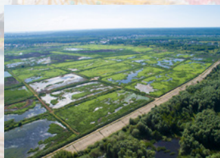
Рекультивация иловых полей биологических очистных сооружений Казани
