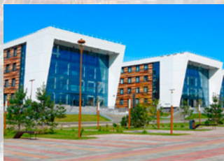
Строительство жилых корпусов Университета Иннополис
